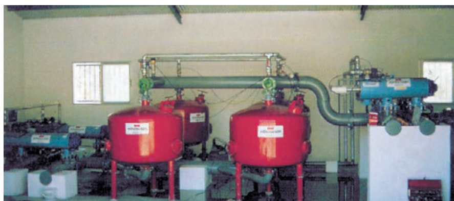
Figura 14. Cabezal de riego localizado.
