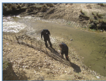
Foto 38. Fase 4: Proceso de la construcción de una empalizada viva de sauce.
