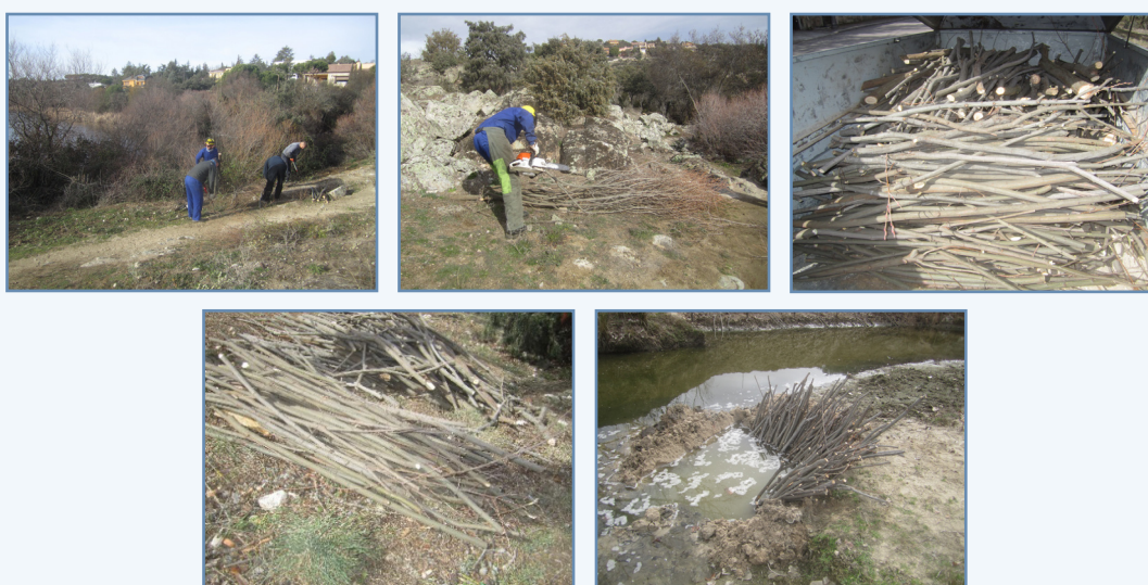
Foto 35. Fase 1: Recolección de estaquillas de sauce: localización de las saucedas madre, corte de las varas para la selección de estaquillas, transporte y acopio a la zona de plantación.
