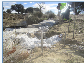
Foto 37. Fase 3: Recorte de estaquillas: corte de la parte aérea por encima de las yemas, dejando de tres a cinco yemas para asegurar el rebrote de la estaquilla.
