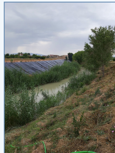
Foto 20. Desbroce de la parte aérea de la caña e instalación de lámina de geotextil para el cubrimiento de la superficie desbrozada en Molina de Segura (Murcia).
