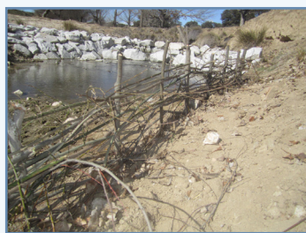
Foto 38. Fase 4: Proceso de la construcción de una empalizada viva de sauce.
