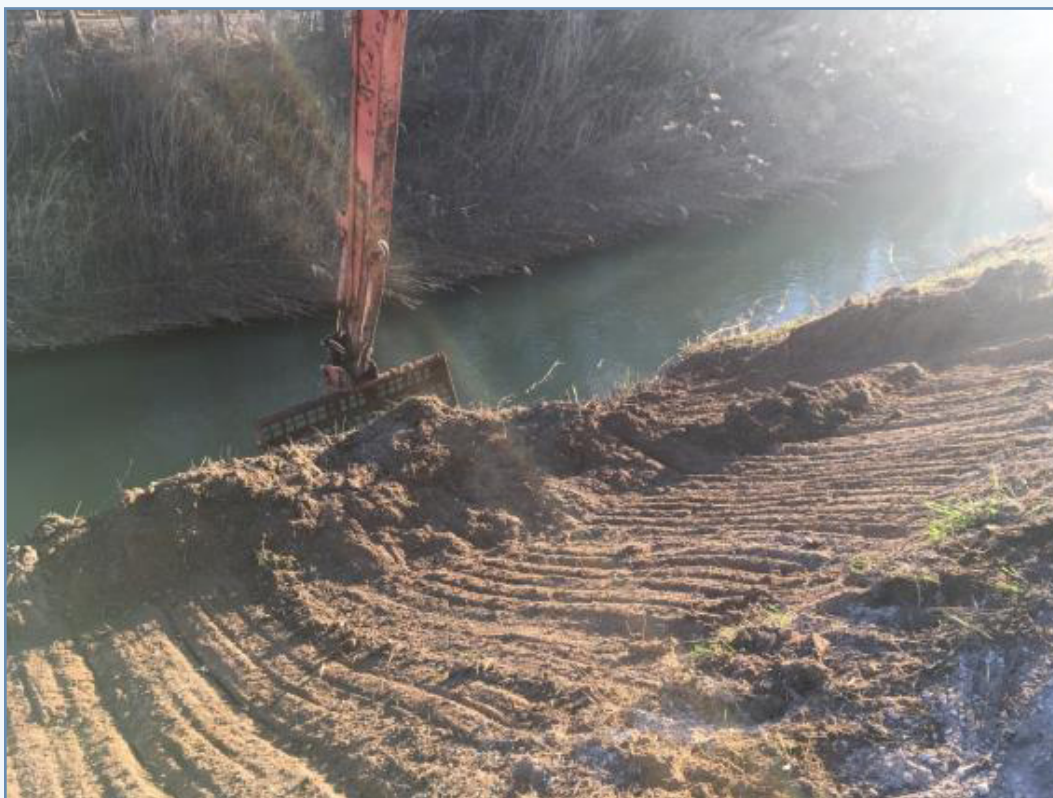
Foto 17. Detalle de la cuchara de excavación con tierra y rizoma.
